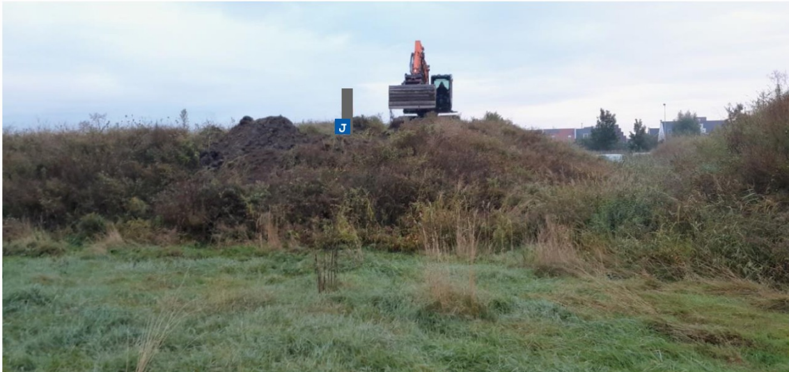
P2024-1223, Depotkeuring Hoevesteinse Lint, Hoef en Haag (4), foto F1
