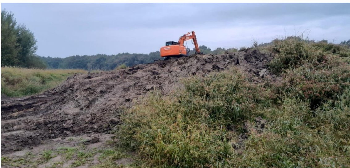
P2024-1223, Depotkeuring Hoevesteinse Lint, Hoef en Haag (4), foto F3
