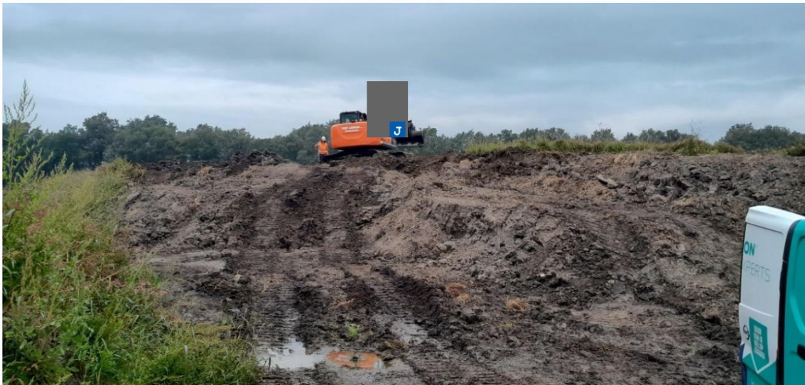
P2024-1223, Depotkeuring Hoevesteinse Lint, Hoef en Haag (4), foto F4
