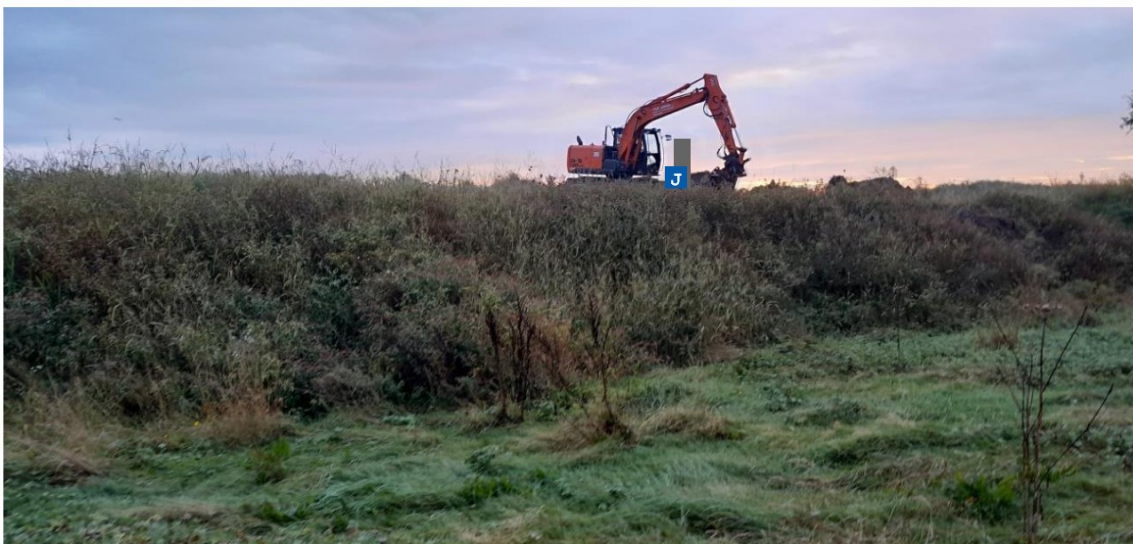
P2024-1223, Depotkeuring Hoevesteinse Lint, Hoef en Haag (4), foto F2
